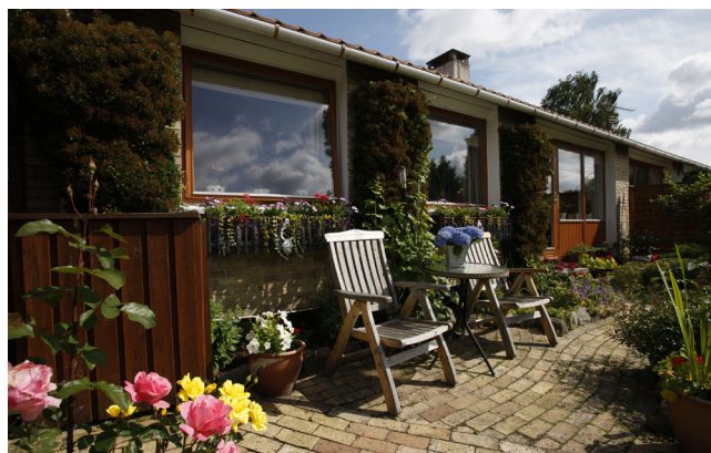
Den almene boligafdeling i Lillerød Boligforening, som udgjorde casen i demonstrationsprojektet, fik renoveret mellembygninger indeholdende bad/toilet, værelse og forrum samt nye køkkener, døre og vinduer inkl. opførelse af nye udhuse i samlet hovedentreprise.
